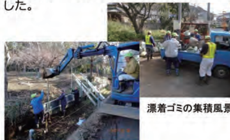
水路の補修風景
