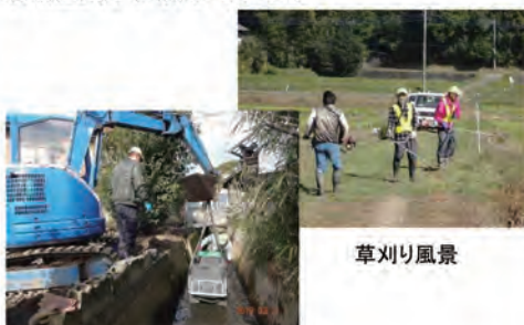
水路の泥上げ風景
